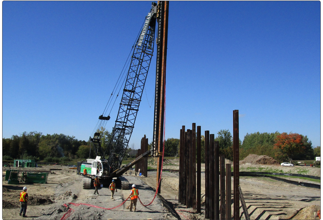
• Mise en place du pieu instrumenté
