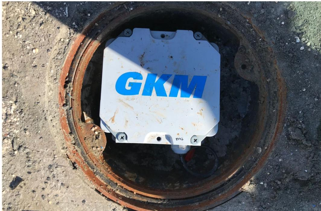
Acquisition de données - en temps réel - intégré dans une boîte de service
