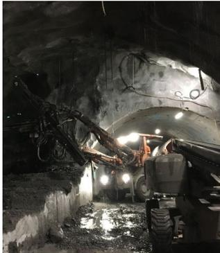
Installation des extensomètres simples dans le tunnel
