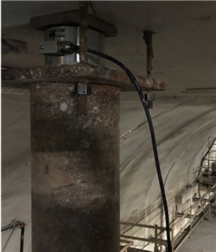
Installation de capteurs de charge entre les supports et le revêtement du tunnel
