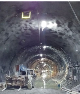
Section équipée de la gaine du tunnel en béton projeté
