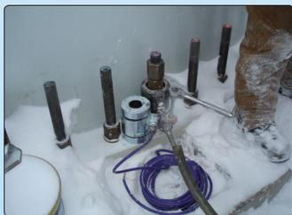
• Installation de cellules de charge aux ancrages
