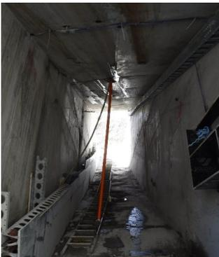
Insertion du tubage de l'inclinomètre à travers la galerie
