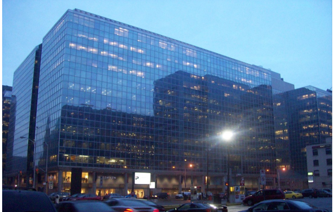
Stationnement souterrain et étages de bureau sur la rue Sparks : surveillance du bruit et des vibrations pendant les travaux de construction
