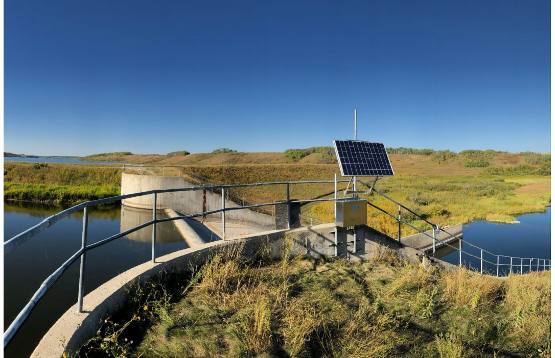
Surveillance à distance intégrée sans fil de l'intégrité structurale | Déversoir du barrage Theodore, Saskatchewan
