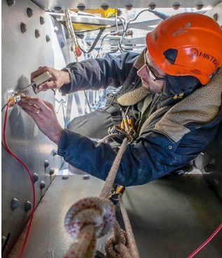
Installation de jauges de contrainte sur une ferme du pont.
