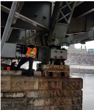
Installation de systèmes d'acquisition de données sous le pont Alexandra.
