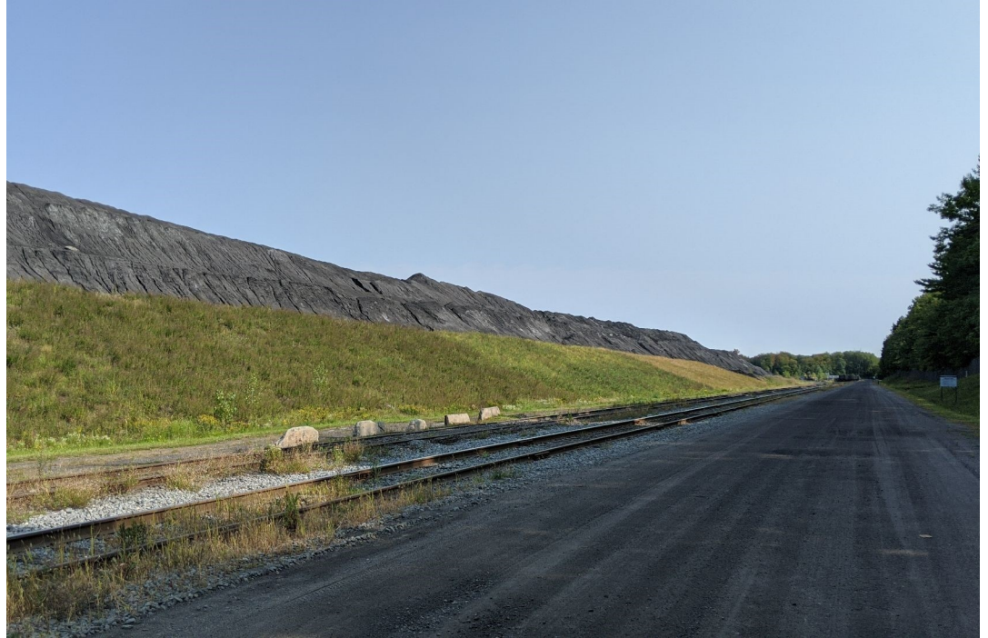
Résidus miniers secs du site P84 - Rio Tinto Fer et Titane (RTFT) situés au Québec | Résidus secs du site actif partiellement assainis.
