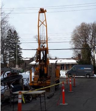
Forage et installation des extensomètres multipoints
