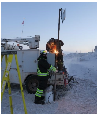
Installation du boîtier et du panneau solaire
