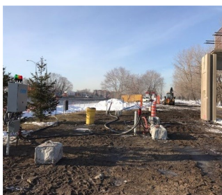
Vue générale du site de construction
