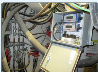
• Mesure de vibration avec des géophones installés sur la structure du tunnelier et dans les sols gelés
