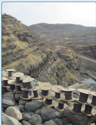
• Câblage des instruments avant branchement aux acquéreurs de données à la salle d'observation en face aval du barrage
