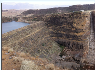
• Vue du batardeau en amont et empreinte du socle pour le barrage en aval
