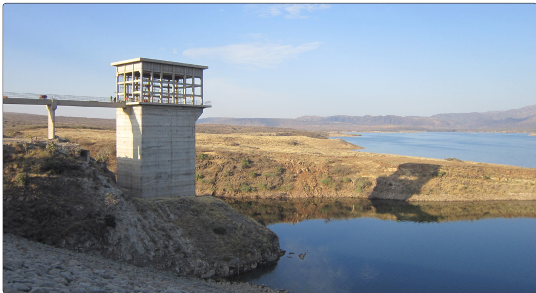
• Tour de prise d'eau
