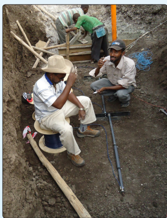
• Installation d'extensomètres de remblai en série
