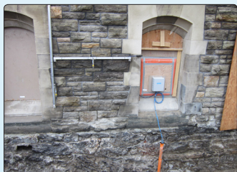
• Clinomètre à barre vertical et horizontal et chaîne inclinométrique en place en bordure de la cour intérieure
