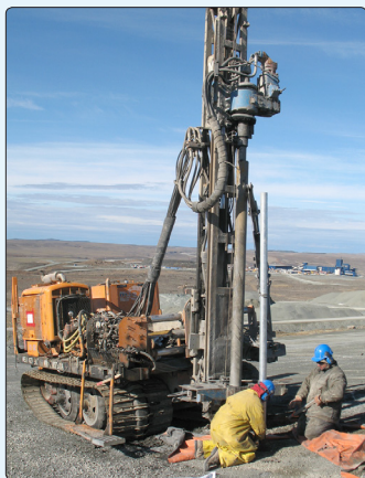
● Installation de chaînes de thermistances, de tige de masse et de poteau
