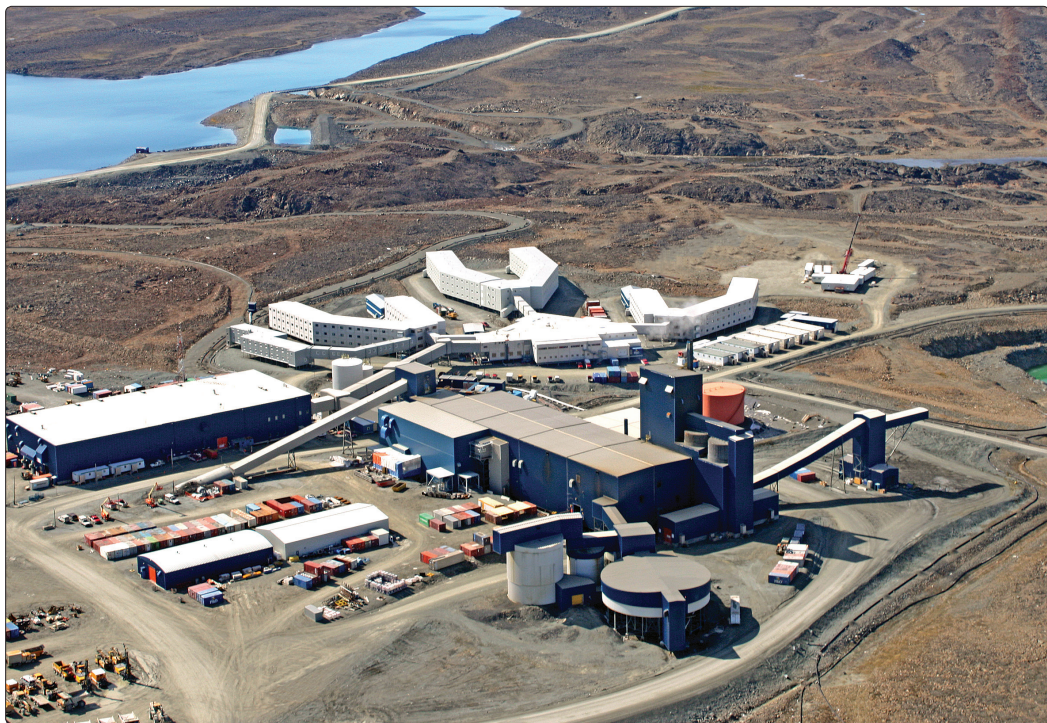
● Vue aérienne de l'usine de traitement
